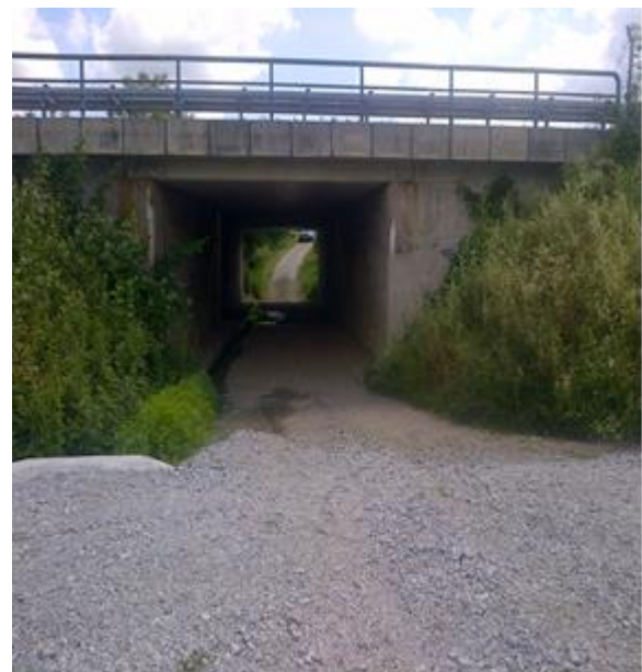
Postojeći putni prolaz ispod autoceste A2
