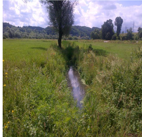
Kanal u stacionaži 0+369.19
