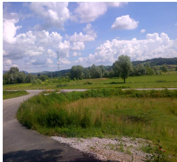
Izvedeni spoj na raskrižje državne ceste D1
